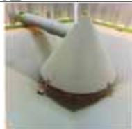
**Aéro-cône avec entrée de ventilation**
