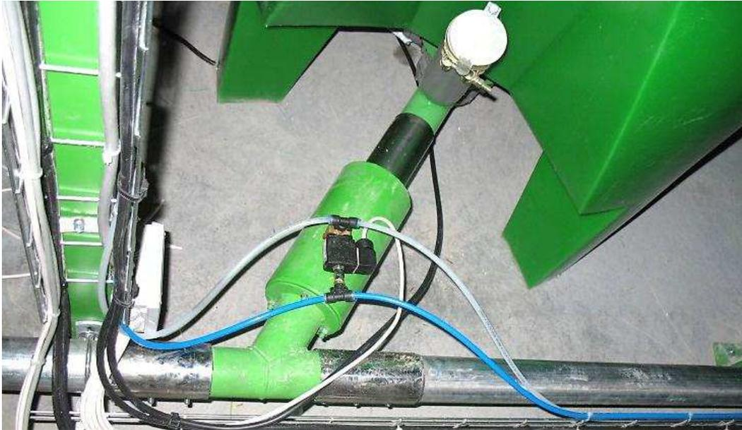
Le retour d'air sur les vannes d'aspiration (tuyau blanc) permet de maintenir les vannes ouvertes pendant l'aspiration des produits et non en refoulement.
