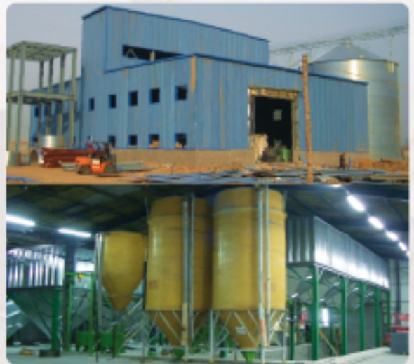
Usine d'aliments volailles - France
